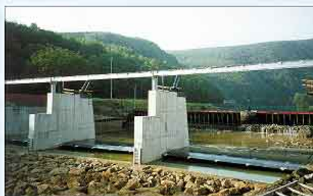
Monthermé: construction du nouveau barrage
