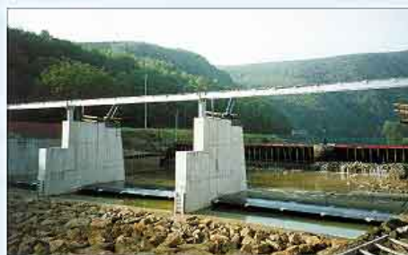
Monthermé: construction du nouveau barrage
