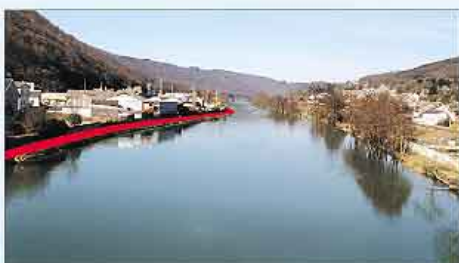
Nouzonville, recalibrage de la rive gauche
