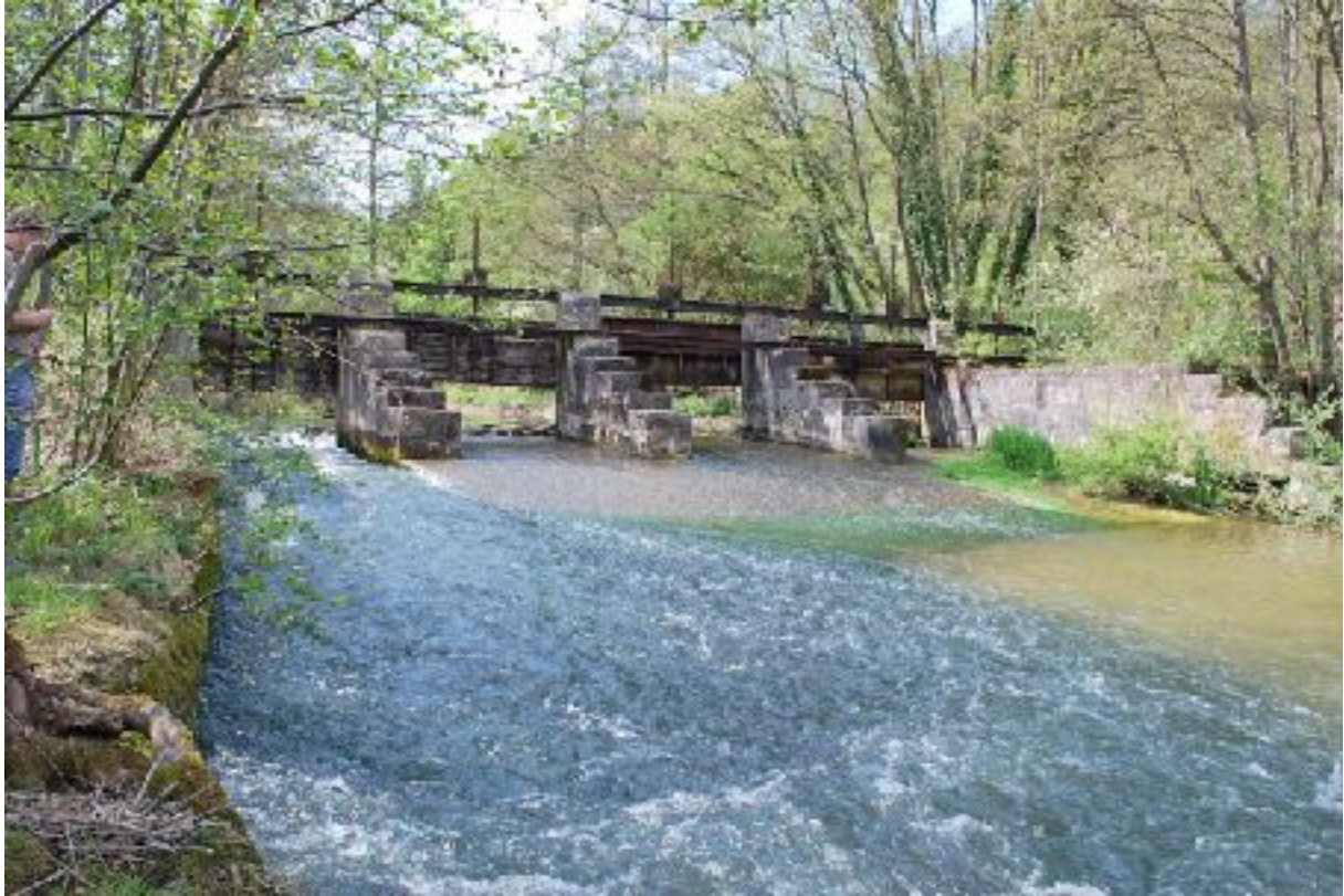
Vannage sur le bras de dérivation à Chatipré (il est prévu de le détruire dans le cadre des travaux)
