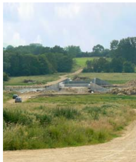
Vue sur la zone d'implantation de la ZRDC (08) juin 2007
