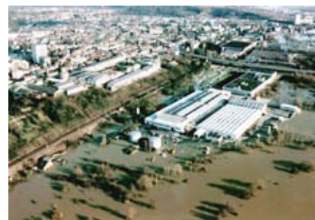
Entreprise inondée à Charleville-Mézières en 1995 (Photo : SNNE)
