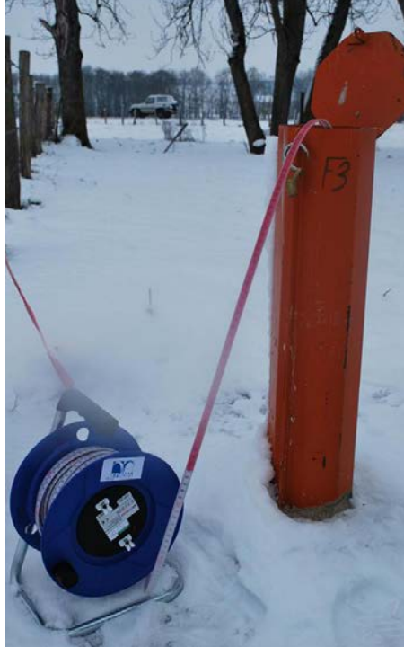
Mesure du niveau d'eau de la nappe dans un piézomètre à Sorcy-Saint-Martin (55)
