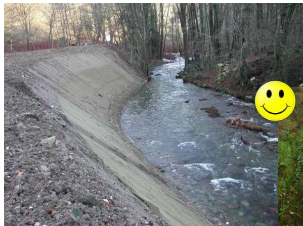
Géotextile et boutures de saules sur la Moselotte
